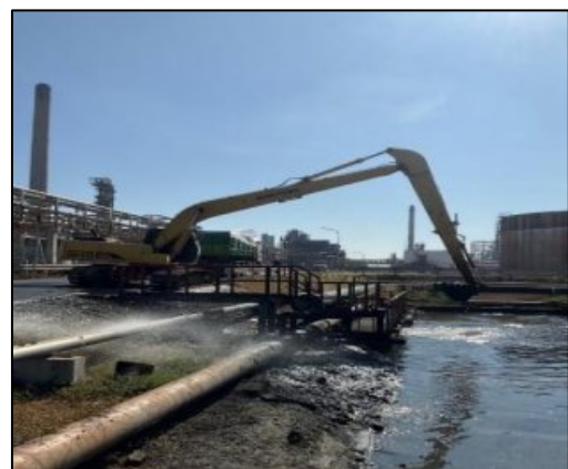
รูปที่ 2-21 การขุดลอกตะกอนในบ่อบำบัดปี พ.ศ. 2567
